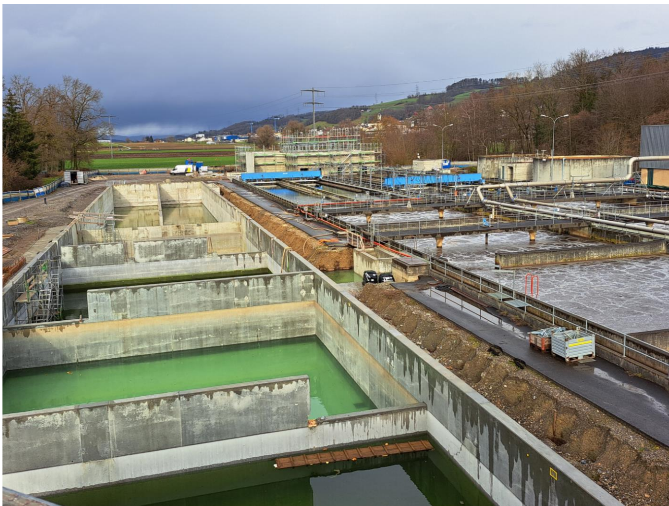
Rohbau der 3. Biologiestrasse und EMV-Anlage (Foto vom 07.01.2025)
